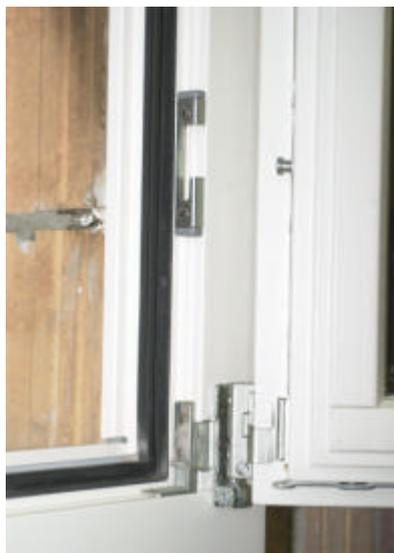
L'ouverture des fenêtres coupe-feu n'est généralement autorisée que pour le nettoyage et l'entretien. Les ferrements doivent répondre à la classe de résistance 2, définie dans la norme EN-V 1627-30.
