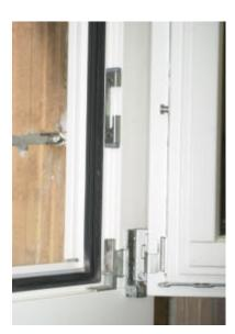
Brandschutzfenster dürfen in der Regel nur bei Reinigungs- und Unterhaltszwecken geöffnet werden. Die Beschläge müssen der in der Norm EN-V 1627-30 definierten Widerstandsklasse 2 entsprechen.
