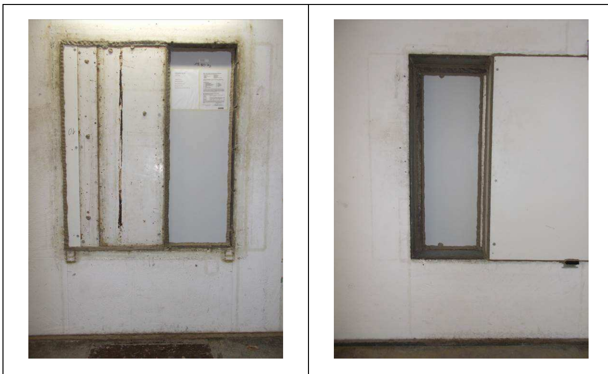
Bild 1 Fotos des eingebauten Elementes, erstellt vom ift Labor Bauakustik
